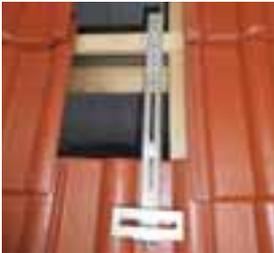
Für das Meranus Solarsystem Premium wurde speziell für die Montage auf Ziegeldächern ein neues Befestigungszubehör entwickelt.
